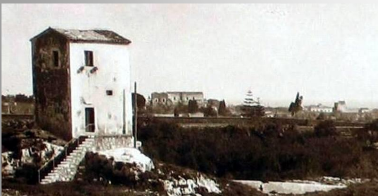
TORRE DI AVVISTAMENTO POI SILOS
